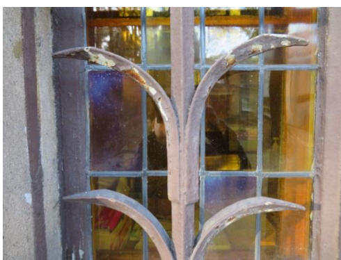
Malowane kraty w oknach skrzynkowych o śladach łuszczenia się farby i wykwitach rdzy.
