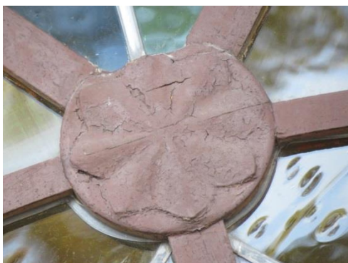
Rozeta drewniana nakładana na witraż w naświetlu drzwi głównych.
