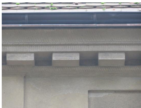
Gzyms klockowy pod okapem dachu.
