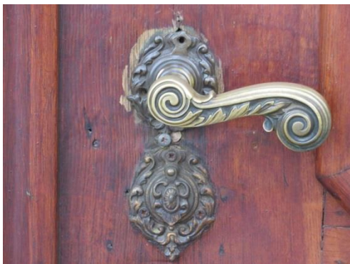
Klamka z szyldem oraz zamek osadzony w drzwiach.
