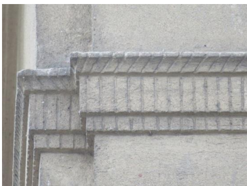
Ryflowane warstwy tynku gzymsu pośredniego umieszczonego pomiędzy oknami a okapem.
