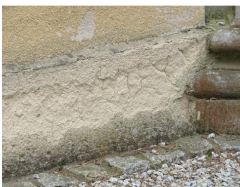
Rozwarstwienie tynku na cokole elewacji.
