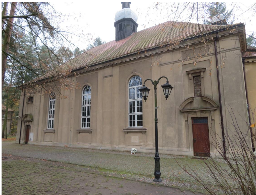
Wzdłużna elewacja od strony północnej z śladami ingerencji cementowej w warstwie cokołu.
