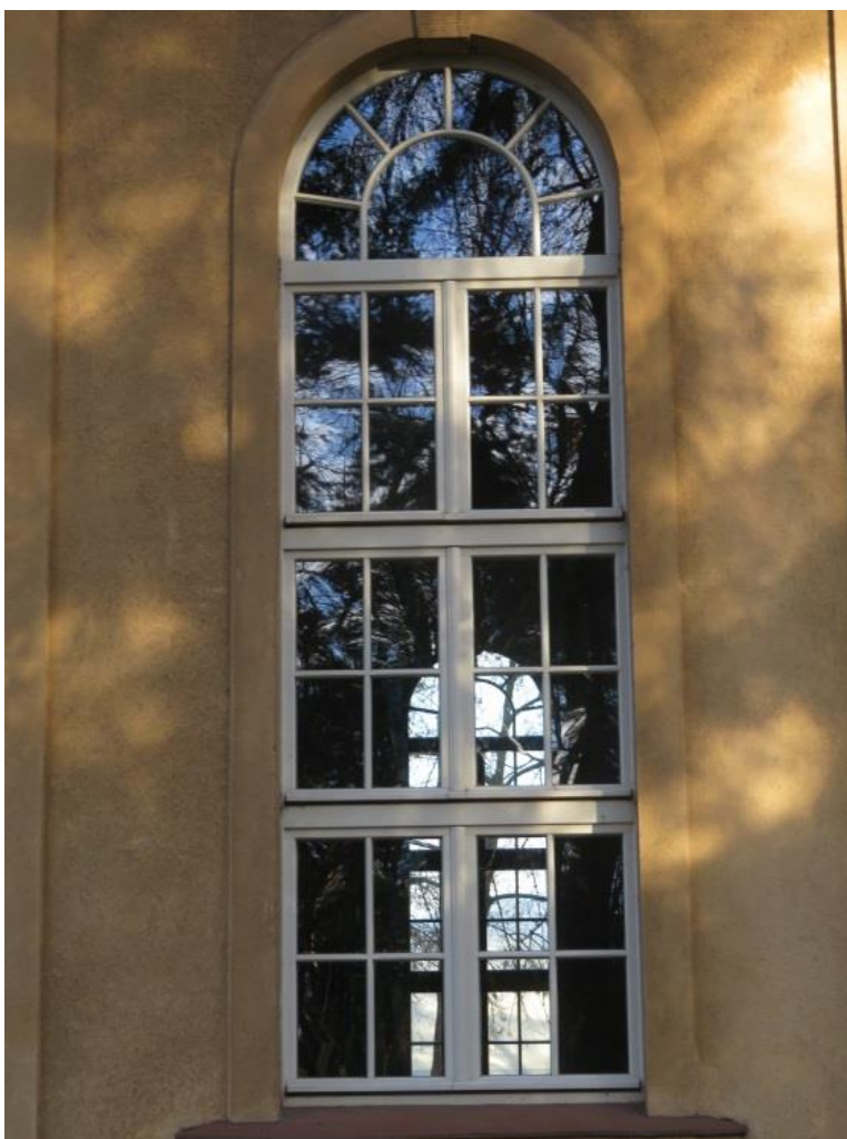
Wtórne okno drewniane doświetlające nawę główną o budowie zespolonej z trzema ślemionami.
