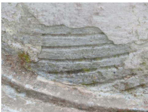
Trzon kolumny pozbawiony miejscowo tynku. Odkryte rowkowanie spiralne.
