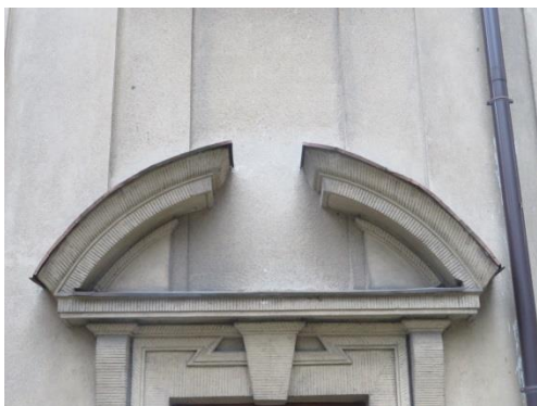
Tynk o różnej fakturze – w polach ściany i przerwanego naczółka segmentowego.
