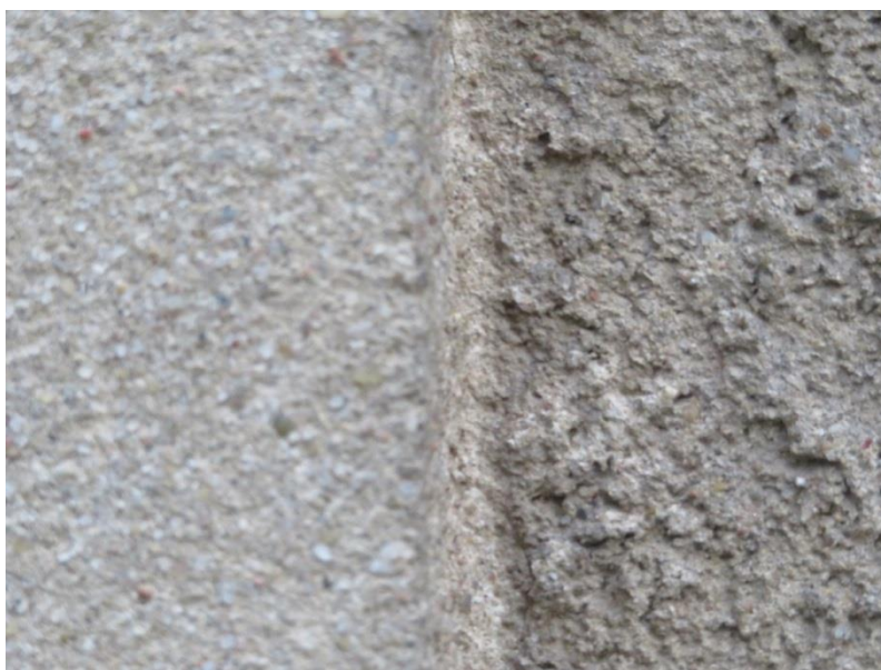
A - tynk obrzutki. B - tynk zatarty wierzchni.
