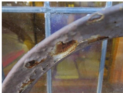
Malowane kraty w oknach skrzynkowych o śladach łuszczenia się farby i wykwitach rdzy.
