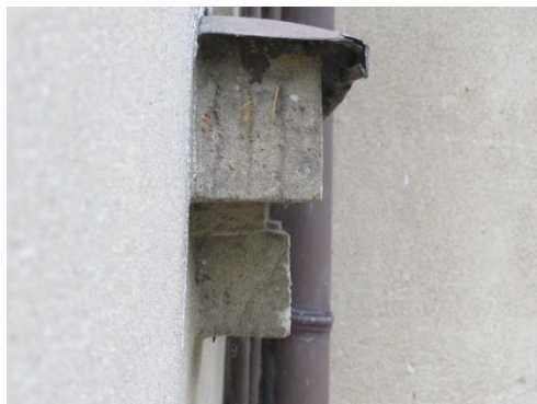
Zniszczone opierzenia blaszane w większości z blachy ocynkowanej malowanej.
