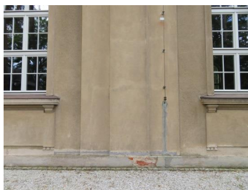
Pole pomiędzy oknami z pionowymi odsadzkami o zróżnicowanej fakturze w tynku.
