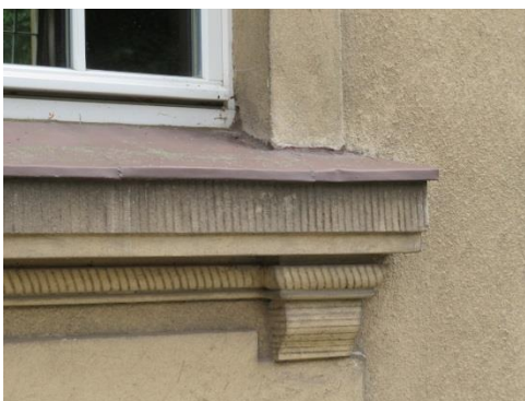
Detal parapetu podokiennego z zastosowaniem wzornictwa prążkowego w tynku.
