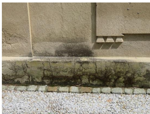
Tynk cokołu pokryty wilgocią i glonami.
