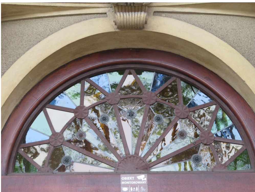
Naświetle głównych drzwi wejściowych o budowie krosnowej wypełnione witrażem.
