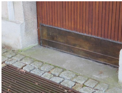
Dolne zabezpieczenia na skrzydłach drzwi bocznych.
