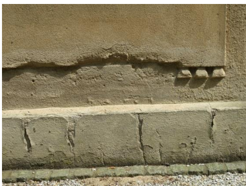
Ubytki i popęknięcia tynku nad cokołem.
