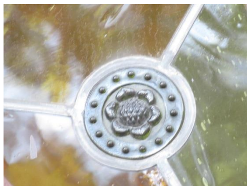
Rozeta metalowa w ramce z ołowiu w witrażu naświetla drzwi głównych.
