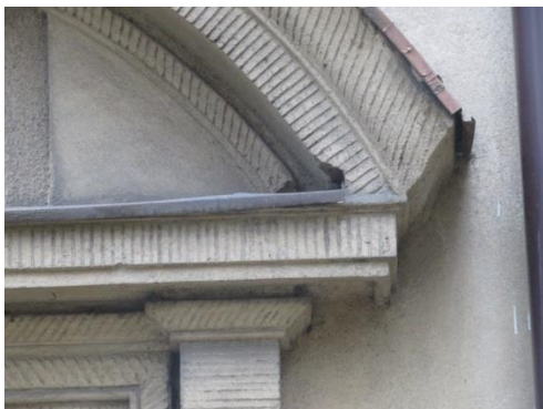
Zniszczone opierzenia blaszane w większości z blachy ocynkowanej malowanej.
