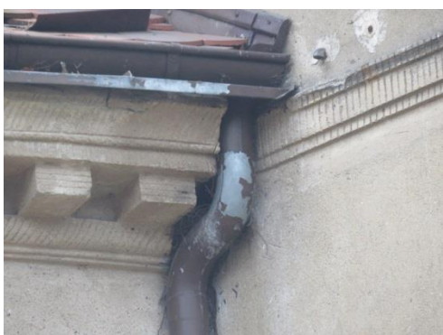
Rynny z blachy malowanej o śladach zniszczeń oraz rury spustowe blaszane i tworzywowe.
